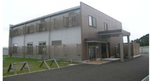
写真 1 エコセンター
