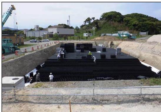
施工中の空隙貯留浸透施設（4基目）
